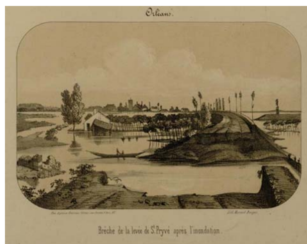
FIGURE 1 : DIGUE SUR LA LOIRE.
