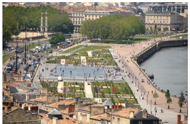
FIGURE 4 : L'AMENAGEMENT DES QUAIS EN BORD DE GARONNE A BORDEAUX. SOURCE : BORDEAUX METROPOLE.
