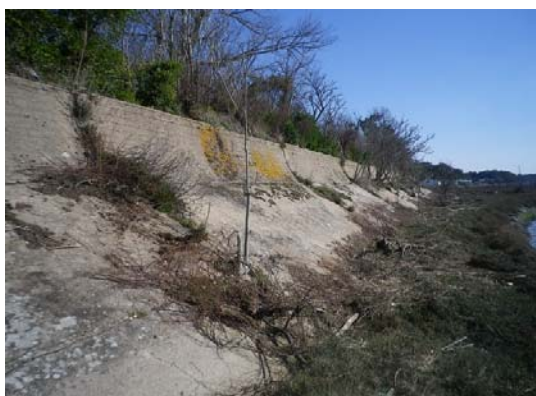
Perré en béton armé, la Tranche-sur-Mer
