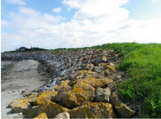
Parement « lisse » en enrochements, Bouin
