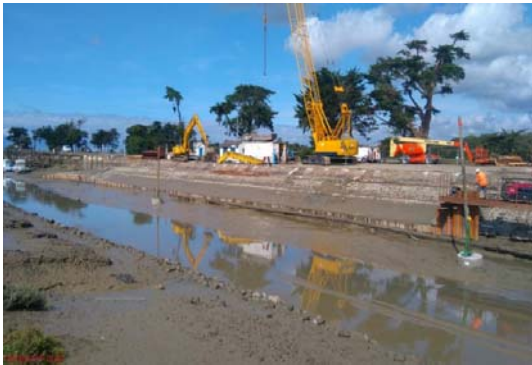
Surcharges en phase de travaux, Villeneuve-en-Retz
