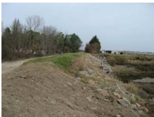
Travaux d'urgence, la Faute-sur-Mer
