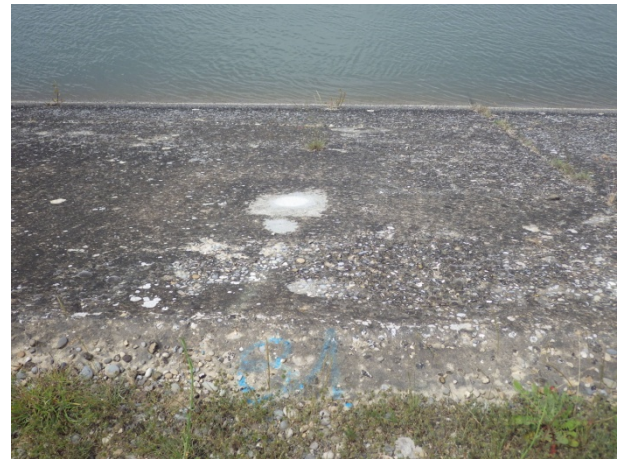
FIGURE 7 : REPARATION PONCTUELLE DE LA ZONE D'IMPLANTATION DE L'ARBRE DEVITALISE
