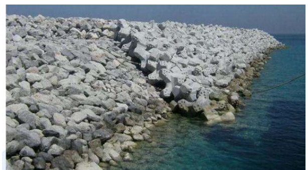
FIGURE 5: CARAPACE EN COURS DE POSE
