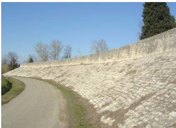
FIGURE 9: PAREMENT AMONT EN PERRE MAÇONNE – DIGUE DE LA MONTAGNETTE – TARASCON (13) (CREDIT BRLI)
