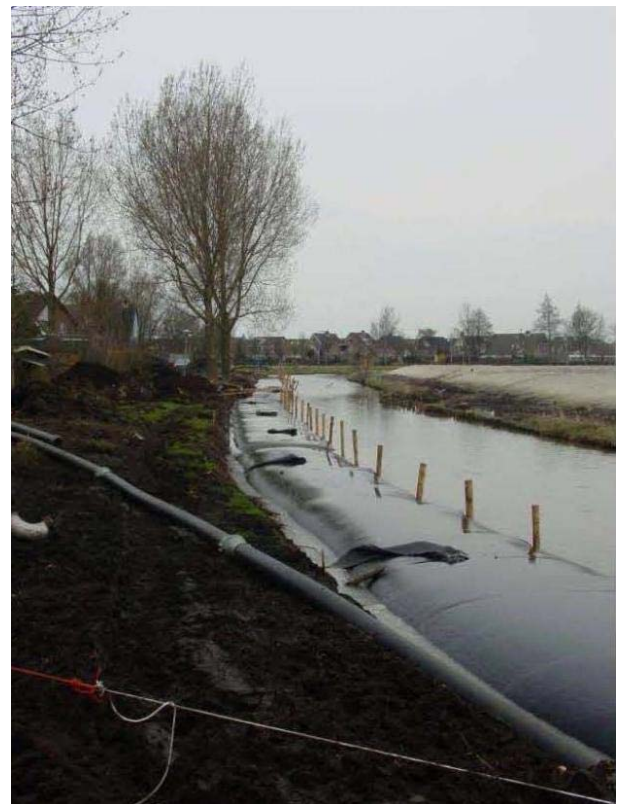
FIGURE 12: REMPLISSAGE D'UN TUBE GEOTEXTILE
