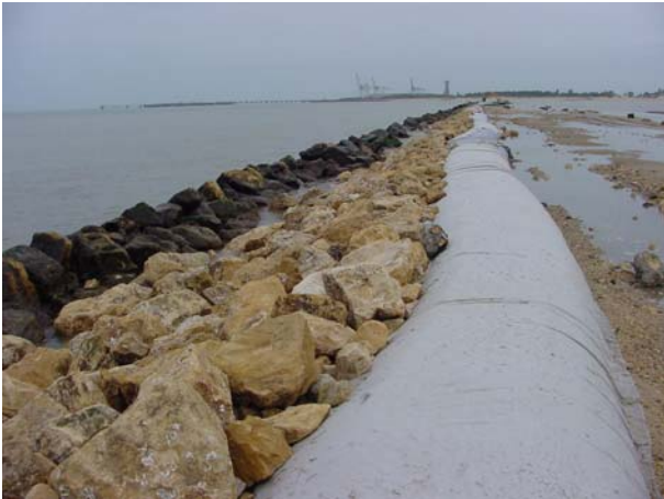
FIGURE 13: CORPS DE DIGUE PORTUAIRE EN CONSTRUCTION PROTEGE DE LA MAREE PAR DES TUBES GEOTEXTILE
