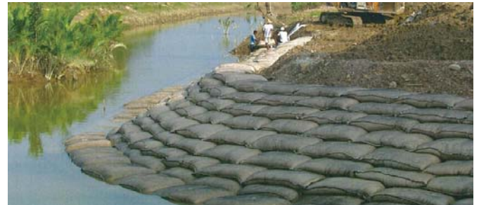
FIGURE 11: PROTECTION PAR DES SACS GEOTEXTILES.
