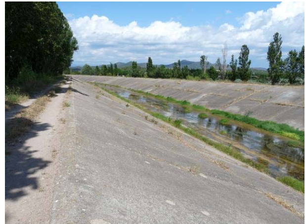
FIGURE 14: DIGUES AVEC PAREMENT ET RADIER EN DALLES BETON SUR LE REYRAN A FREJUS (83)
