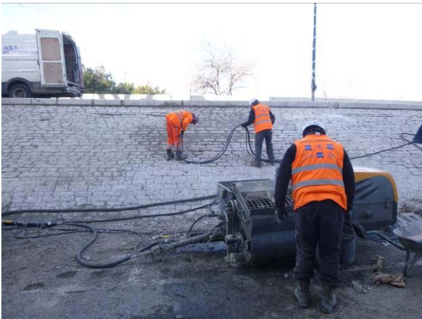
FIGURE 10: REJOINTOIEMENT AU PISTOLET – DIGUE DE LA MONTAGNETTE – TARASCON (CREDIT BRLI)
