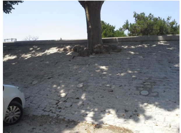
FIGURE 11 : PAREMENT REJOINTOYE AVEC EQUIPEMENT DE TUBES EJECTEURS (© BRLi)
