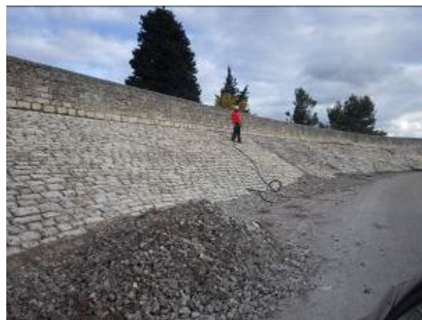
FIGURE 9 : OPERATION DE PIQUAGE DES JOINTS (© BRLI)
