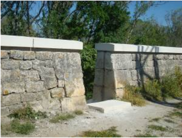
FIGURE 10 : ATTEINTE DE LA COTE « MILLENALE » PAR POSE DE PIERRES DE COURONNEMENT (© BRLi)
