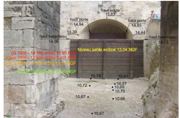
FIGURE 5 - VUE DU BATARDEAU SUR LA POTERNE (© BRLI)
