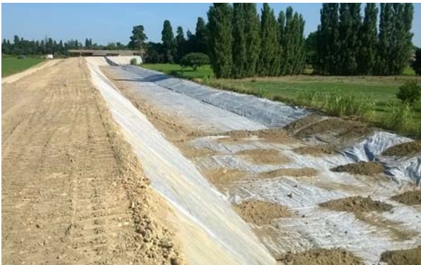
PHOTO 2: VUE D'ENSEMBLE DU GEOCOMPOSITE AVANT REALISATION DE LA RECHARGE AVAL
