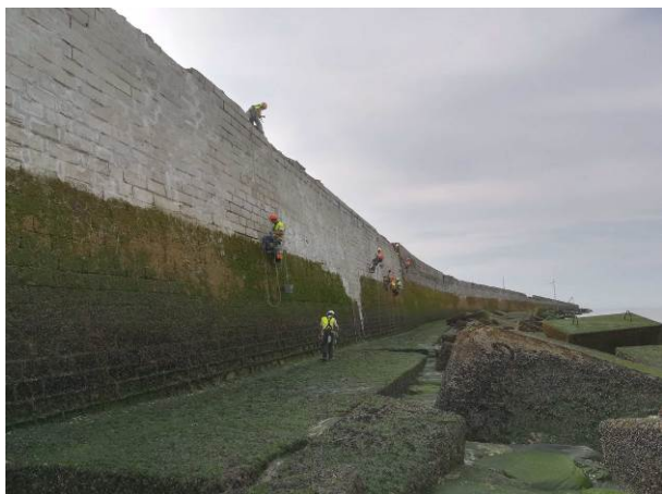
FIGURE 12 : TRAVAUX DE REPARATIONS DE LA MURAILLE EN MAÇONNERIE AU MOYEN DE CORDISTES - MAREE BASSE - SOURCE : VALETUDES
