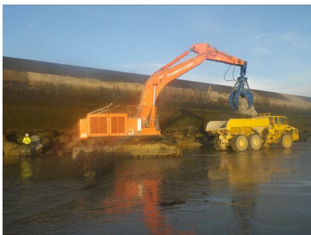
FIGURE 10 : RECHARGEMENT DE LA CARAPACE A L'ENRACINEMENT A MAREE BASSE - SOURCE : VALETUDES
