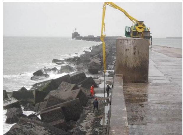
FIGURE 9 : CONFORTEMENT DES RISBERMES A MAREE BASSE - SOURCE : VALETUDES
