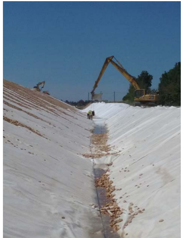
FIGURE 10 : CÂBLE OPTIQUE EN COURS DE POSE EN FOND DE BECHE
