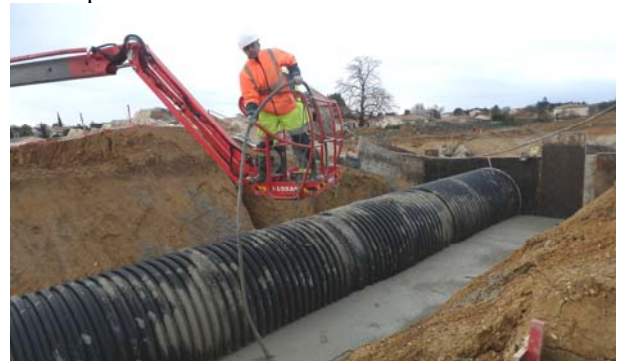
PHOTO 4 : REMBLAI D'OUVRAGE EN BETON PLEINE FOUILLE AVEC ANTI-RENARD FERRAILLES (©BRLi)
