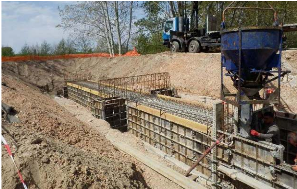
PHOTO 2 : OUVRAGE TRAVERSANT EN BETON ARME (©BRLi)
