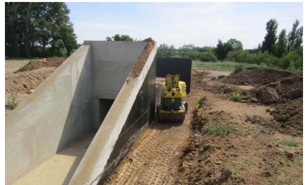
PHOTO 3 : REMBLAI D'OUVRAGE AVEC ROULEAU VIBRANT A PIED DE MOUTON (VP1) (©BRLi)
