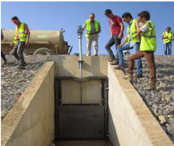
PHOTO 6 : TEST D'ETANCHEITE SUR UNE VANNE (©BRLi)
