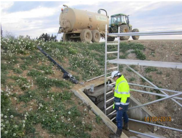
PHOTO 5 : CAISSON DEVANT LE CLAPET (©BRLi)
