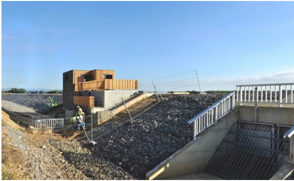
PHOTO 8 : OUVRAGES DE GESTION HYDRAULIQUE TRAVERSANT ET DE POMPAGE APRES ELEVATION DE LA DIGUE (©BRLi)
