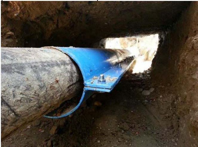
PHOTO 1 : FOURREAU DOUBLE COQUE (©BRLI)
