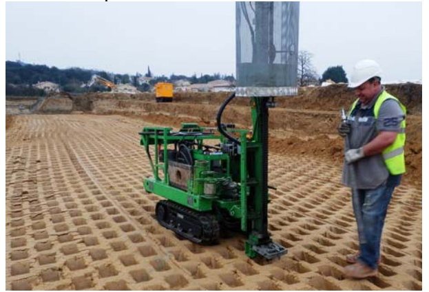
PHOTO 9 : ESSAI DE COMPACTAGE AU PENETROMETRE DYNAMIQUE (©BRLi)
