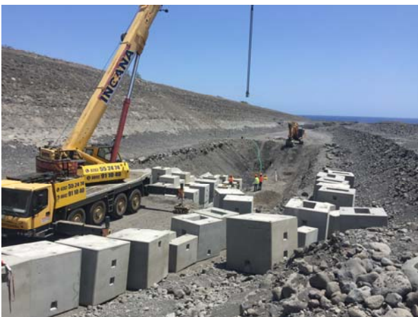
FIGURE 28 : MISE EN ŒUVRE DE LA PLANCHE D'ESSAIS - © BRLINGENIERIE
