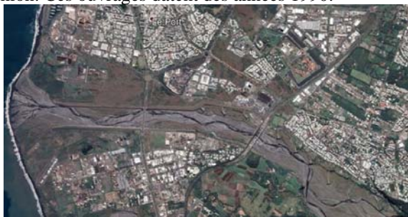
FIGURE 1 : VUE DE LA PARTIE AVAL DE LA RDG
