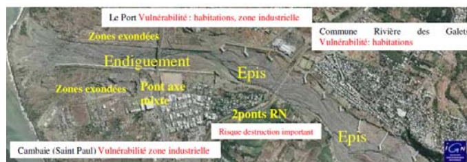
FIGURE 3 : LES OUVRAGES DE PROTECTION DE LA RIVIERE DES GALETS ET LEURS EFFETS
