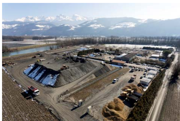
FIGURE 8 : STOCKAGE SUR STATION DE LAVAGE CONCASSAGE CRIBLAGE (SLCC)
