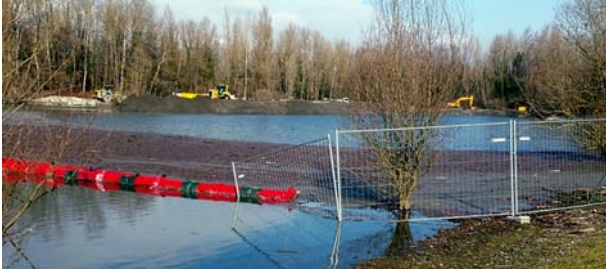
FIGURE 10 : SITE DE DEPOT DES MATERIAUX POLLUES PAR LES INVASIVES (AVEC LA BARRIERE FLOTTANTE AU PREMIER PLAN A GAUCHE)
