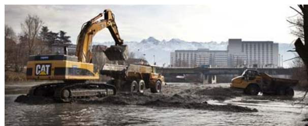
FIGURE 4 : ARASEMENT DE BANC DANS GRENOBLE (BANC IMMERGE)
