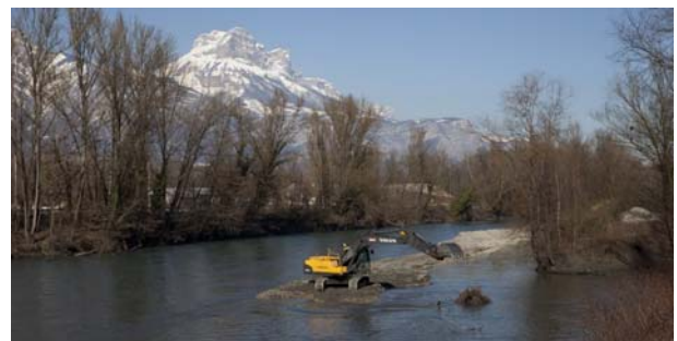
FIGURE 11 : CURAGE INITIAL D'UNE PLAGE DE DEPOT DANS LE LIT DE L'ISERE
