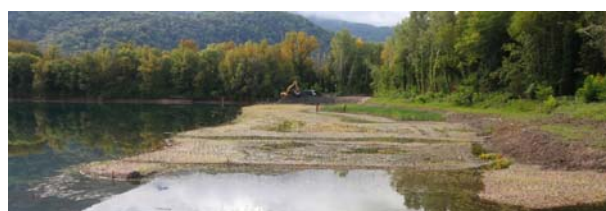
FIGURE 7 : EXEMPLE DE REEMPLOI DE MATERIAUX POUR RECONSTITUTIONS DE HAUTS FONDS DE ROSELIERE
