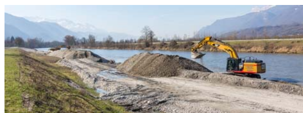
FIGURE 5 : ARASEMENT DE BANC EMERGE LE LONG DE LA BERGE (TRANCHE 2, AMONT)
