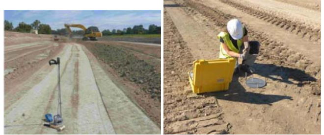
FIGURE 7: ESSAI AU PENETROMETRE DYNAMIQUE LEGER ET ESSAI A LA JED PAR LE CONTROLE EXTERIEUR
