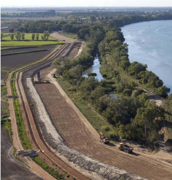
FIGURE 7 : PRESERVATION D'UNE ZONE HUMIDE EXISTANTE PAR EVITEMENT ET REcul DU TRACE DE DIGUE
