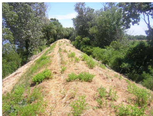
FIGURE 1 : DIGUE DU GRAND RHONE RIVE DROITE VUE VERS L'AVAL
