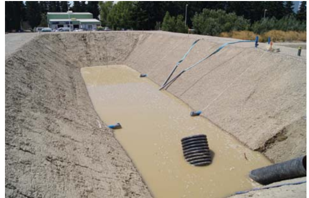
FIGURE 2 : VUE DU DEMONSTRATEUR CONSTRUIT EN ARLES
