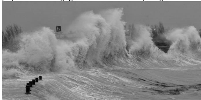
FIGURE 3: EXEMPLE DE FRANCHISSEMENTS PAR PAQUETS DE MER SUR LE PERRÉ DE SAINT-JEAN-DES-SABLES
