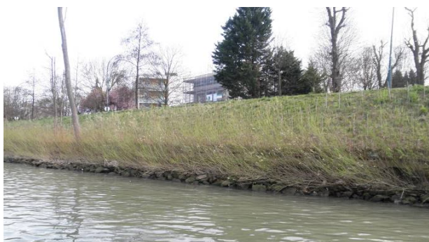
PHOTO 3 - AMENAGEMENT DE LA BERGE PAR GENIE ECOLOGIQUE APRES 1 AN
