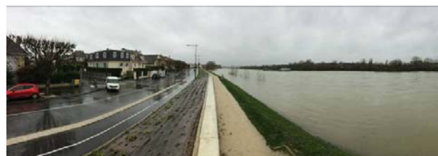
PHOTO 4 - LA DIGUE DE SARTROUVILLE DURANT LA CRUE DE JANVIER 2018
