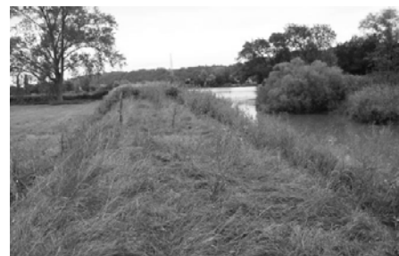
FIGURE 9. : AMENAGEMENT DE L'ESTEY D'EYRANS, UNE ANNEE APRES TRAVAUX [13]
