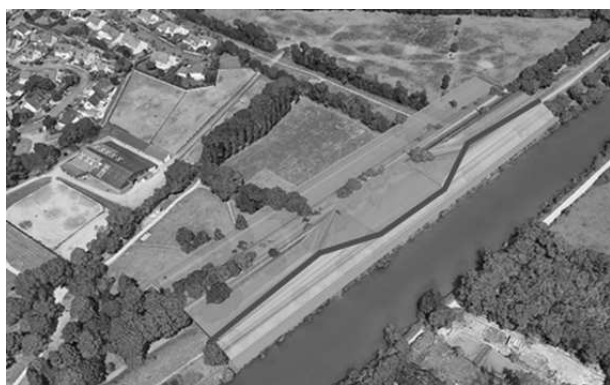
FIGURE 9 : ÉCHANCRURE DANS LE REMBLAI DE L'AUTHION SUR LE SECTEUR DE GUILLEBOTTE
