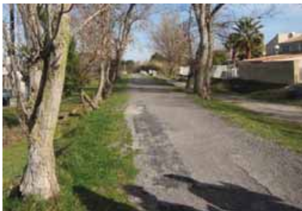
FIGURE 4 : DIGUE AVEC PISTE CYCLABLE EN CRETE
