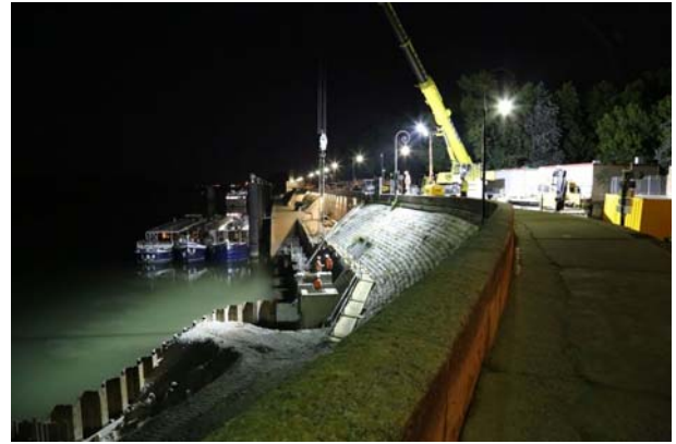
FIGURE 22 : POSE DES ELEMENTS PREFABRIQUES DE NUIT
