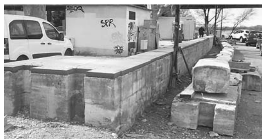
FIGURE 15 : REHAUSSE DES PARAPETS
