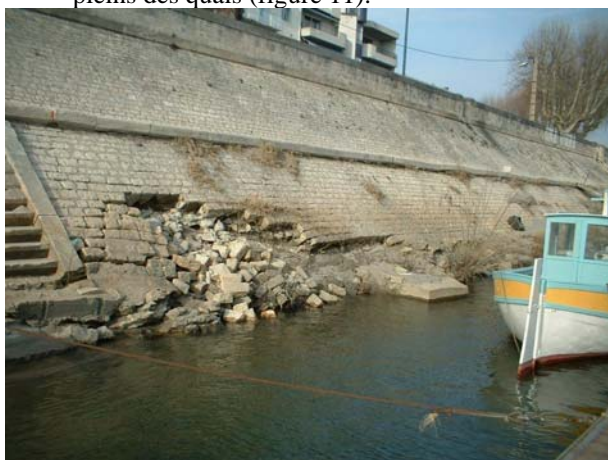
FIGURE 8 : DISLOCATION DE PERRE EN PIED
