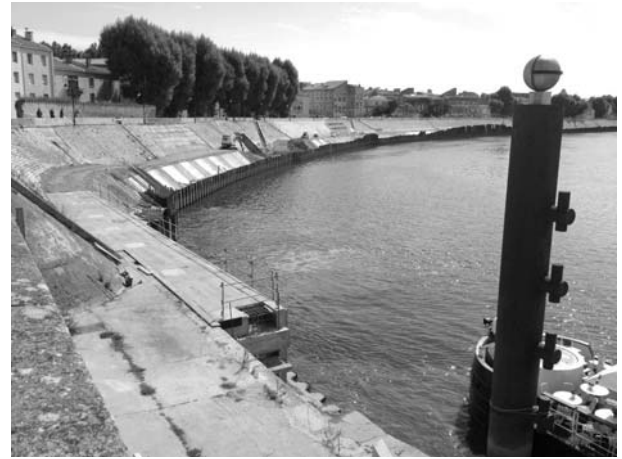
FIGURE 19 : QUAI SUR PIEUX ET QUAI MARX DORMOY EN COURS TRAVAUX
