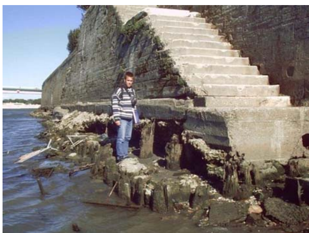
FIGURE 9 : FONDATION DES MURS DE QUAÏ
