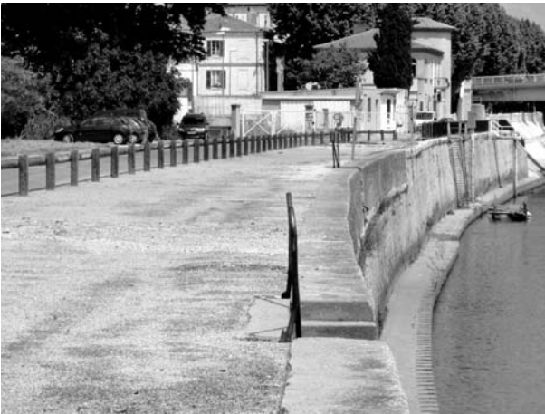
FIGURE 5 : QUAÏ DE LA GARE MARITIME
