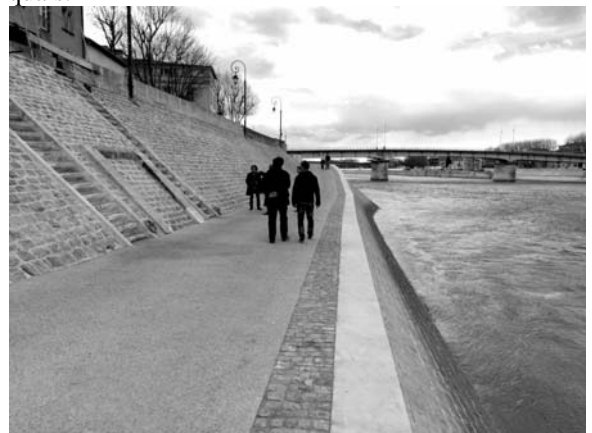
FIGURE 20 : REVETEMENTS DE SURFACE APRES TRAVAUX
