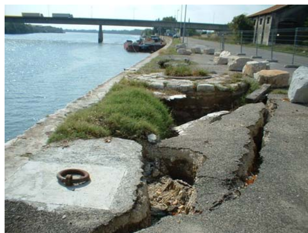
FIGURE 11 : FONTIS AU DROIT D'UN OUVRAGE PLUVIAL
