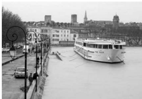
FIGURE 16 : AMARRAGE D'UN BATEAU HOTEL SUR LE QUAÏ DU 8 MAI 1945 LORS DE LA CRUE DE DECEMBRE 2003
