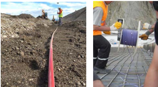
FIGURE 7 : GAUCHE, DIGUE DE LA SAVE (SLOVENIE) DROITE, BARRAGE DE BAGBASI (TURQUIE)
