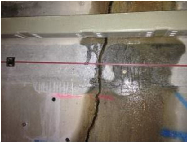
FIGURE 12 : INSTALLATION DANS LE TUNNEL D'ACCES
