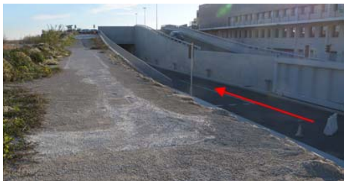
FIGURE 9 : CHENAL D'EVACUATION DES EAUX DE SURVERSE
