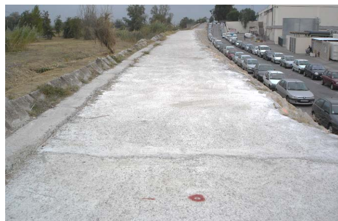
FIGURE 8 : DIGUE APRES TRAVAUX (2007)
