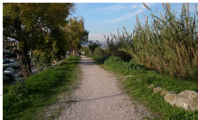
FIGURE 7 : DIGUE AVANT TRAVAUX (2005)
