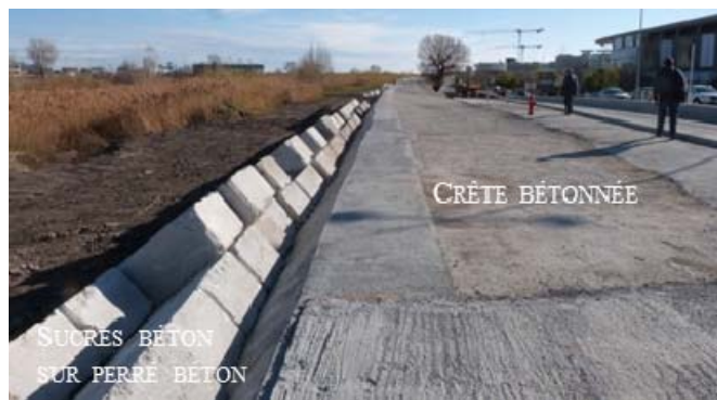
FIGURE 10 : DIGUE CAP 3000 CONFORTEE EN 2017
