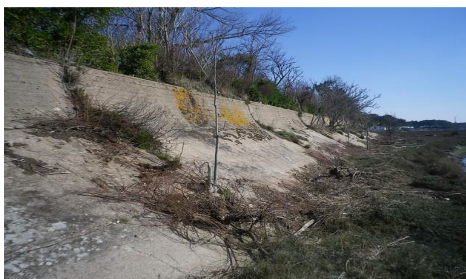
Perré bétonné – Crédit : DREAL Pays de la Loire
