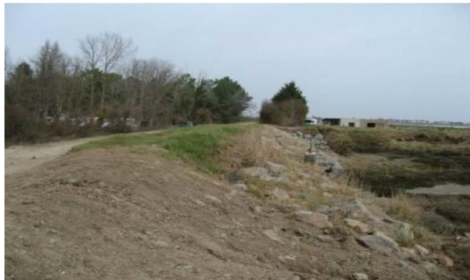
Travaux d'urgence – Crédit : DREAL Pays de la Loire
