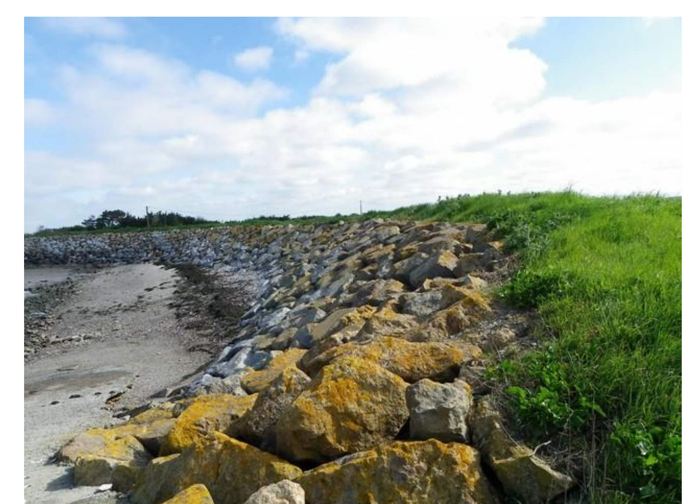
Enrochements « lisses » - Crédit : DREAL Pays de la Loire
