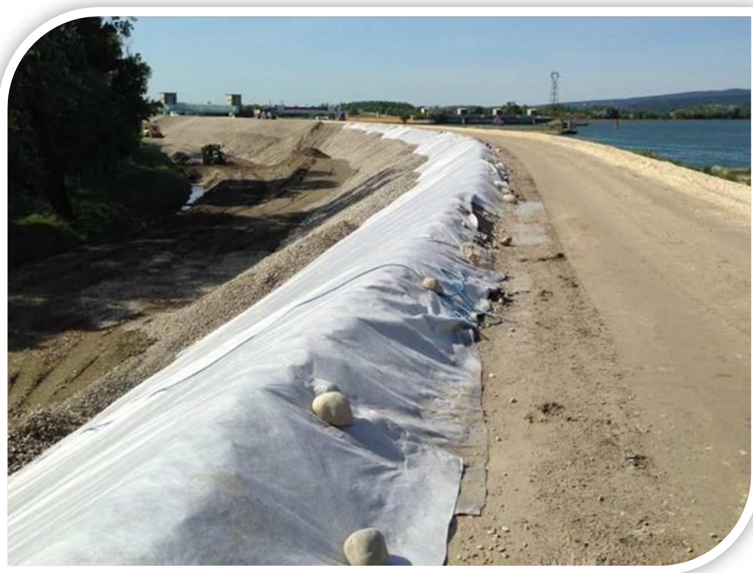
Géotextile de filtration sous recharge drainante (26)
