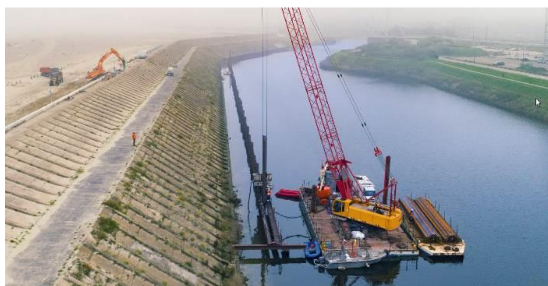
Atelier de battage (source NGE Fondations)
