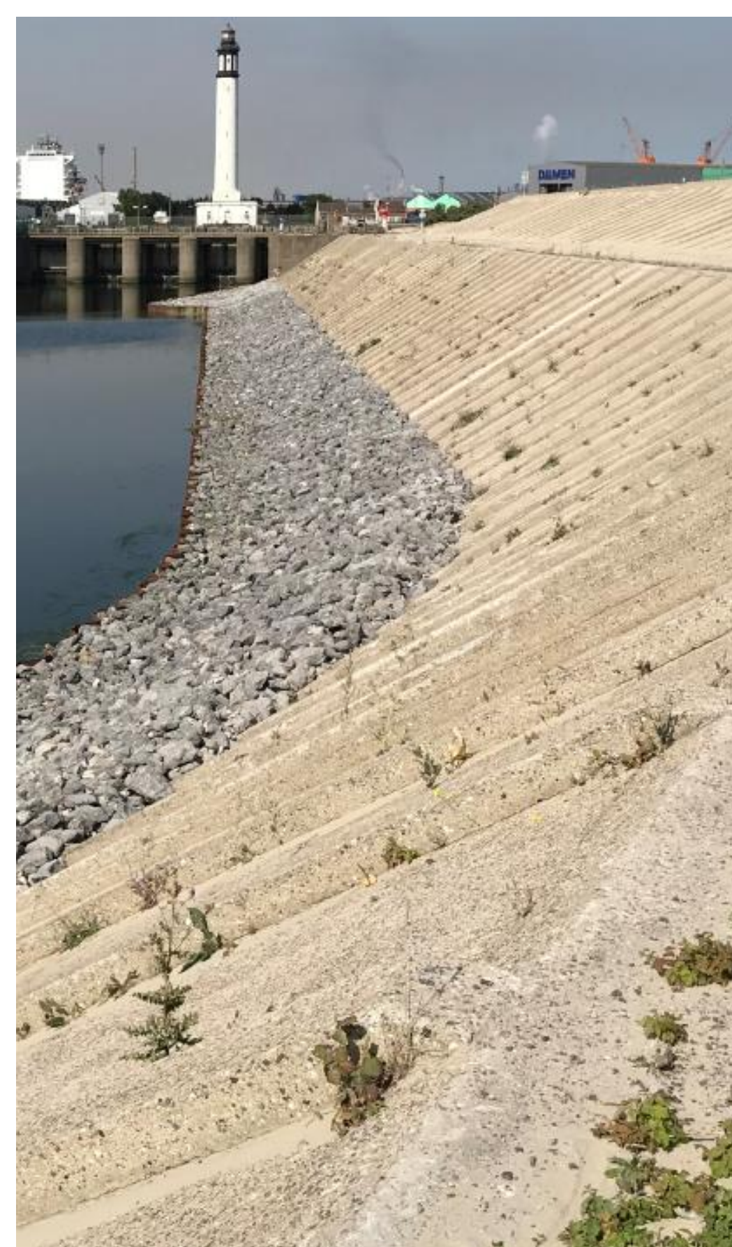
Dispositif de filtration / drainage (ISL)
