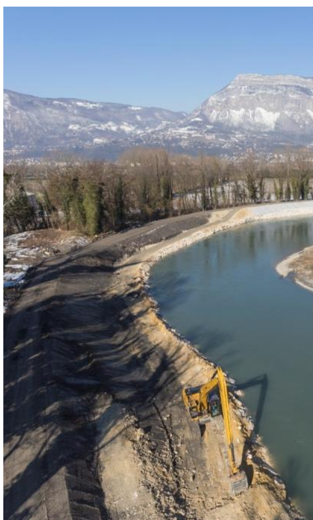
Travaux de confortement de la digue de l'Isère (Symbhi)
